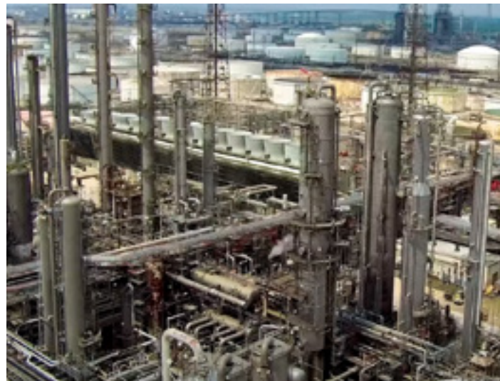
Imagen: “Refinería Deer Park (construida en 1929) que compró Pemex” en reporteindigo.com en https://tinyurl.com/5akf8bfm
