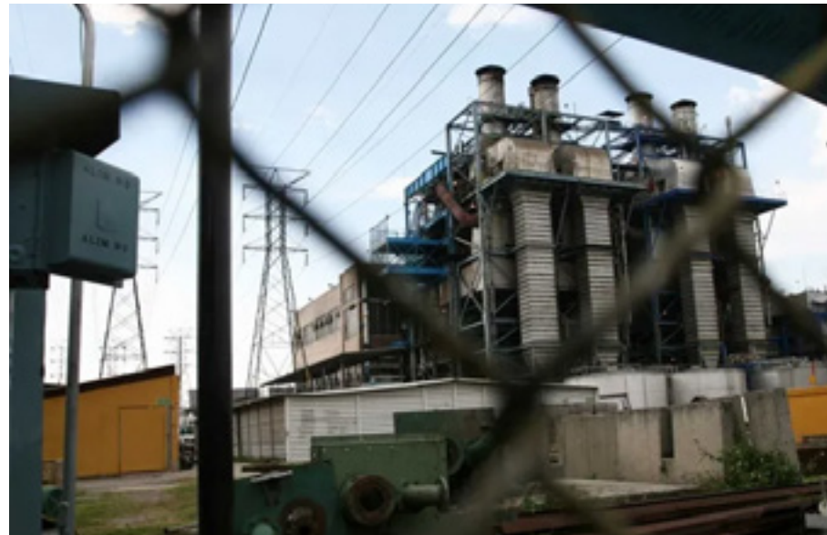
Imagen; Instalaciones de la Central Termoeléctrica “Ing. Jorge Luque”. Foto: Cuartoscuro en https://yancuic.com/2019/02/11/modernizara-cfe-60-plan-tas-termoelectricas-en-el-pais/
