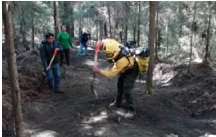
Imagen: Construcción de brechas contrafuegos en https://www.elsoldetlaxcala.com.mx/local/inician-apertura-de-brechas-cortafuego-7793954.html
