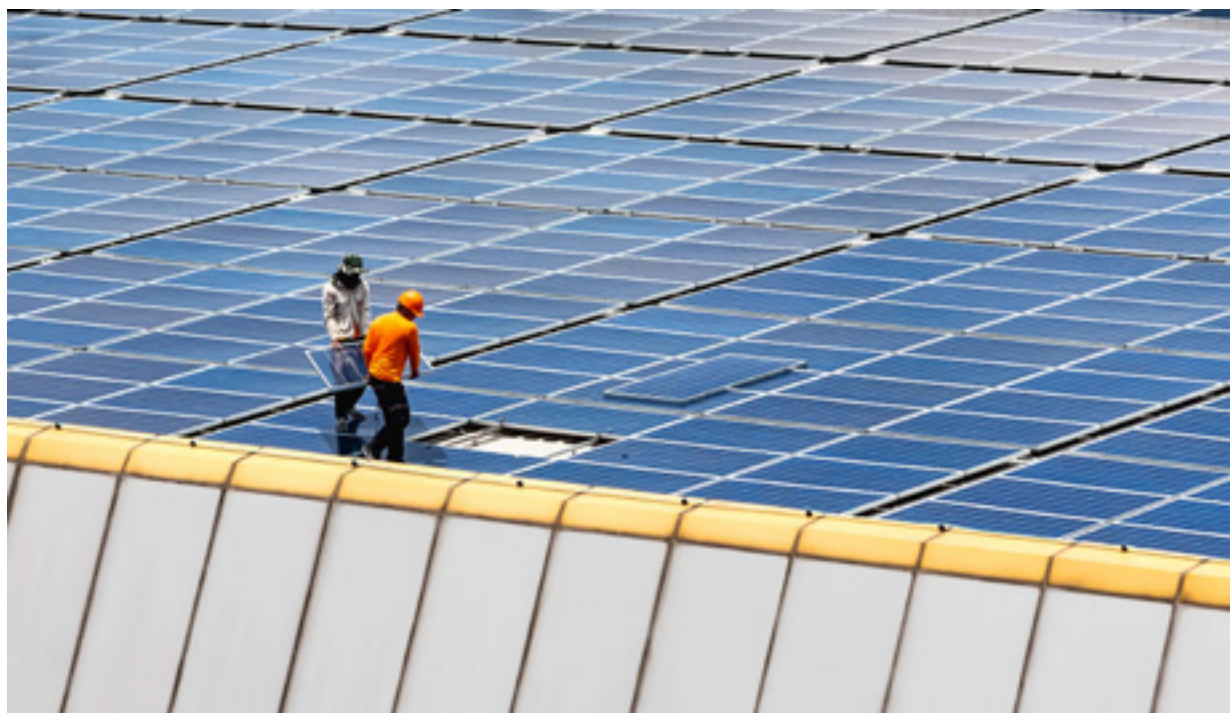
Imagen: "La energía renovable que México está perdiendo" en https://expansion.mx/opinion/2022/07/06/energia-renovable-mexico-esta-perdiendo
