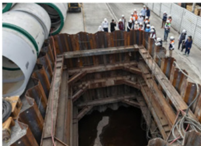
Imagen: Colector Chalco en https://www.chilango.com/noticias/asi-avanzan-las-obras-del-colector-de-chalco-cuando-quedara-listo/
